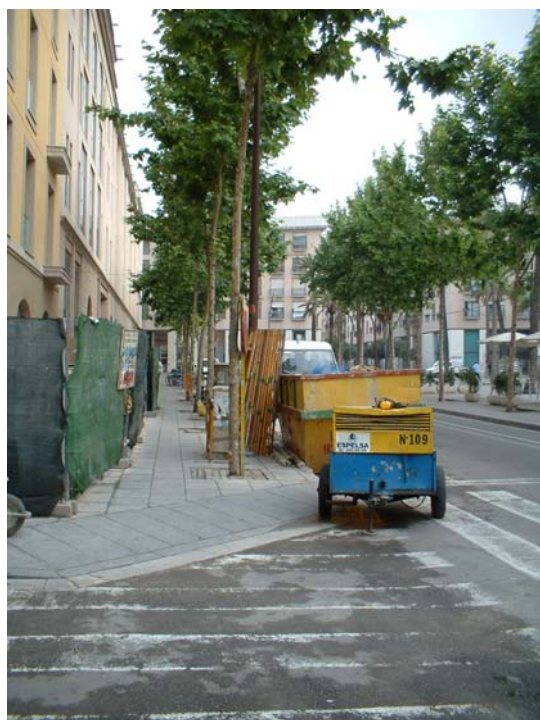
Fotografia 2: Vista general del tram de la Rambla del Raval afectat per l'obra.
