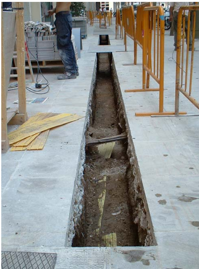
Fotografia 5: Vista parcial de la Rasa 200.
